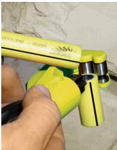
Corte con corta-tubo en obra.
