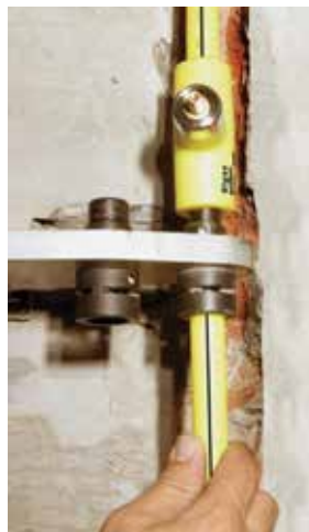
Thermofusión en la canaleta.
