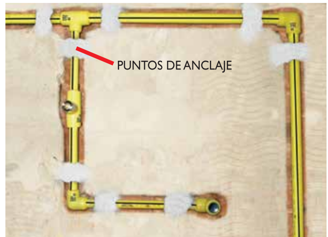
Vista parcial de instalación.
